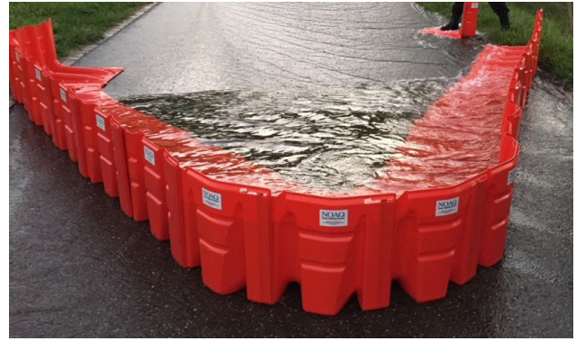
Boxwall als temporäres Rückhaltebeckensetzt.
